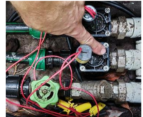
Belüftungsschraube des Magnetventils
